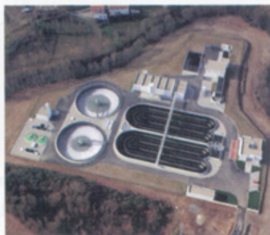
Estação de tratamento de águas residuais de Serzedo
